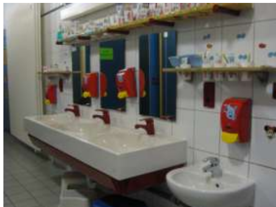
Waschraum vom Gruppenraum zugänglich
