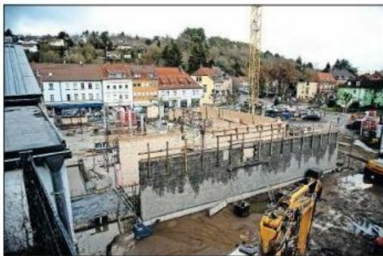
Der Rohbau auf dem Emrich-Gelände entsteht.
