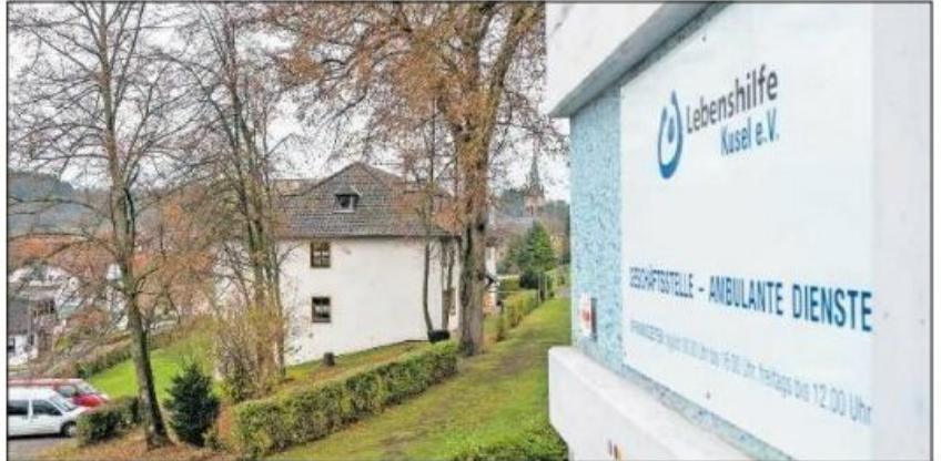
Die Geschäftsstelle im Christian-Böhmer-Weg und im Hintergrund das Wohnheim.
